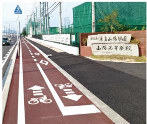
生徒の約7割が自転車で通学する山陽高校。この度、県道南観音観音線の大改修工事が行われ、広島市内初の自転車専用道路が整備されました。4車線化された車道の両端に設けられた自転車専用道路の幅は2.5メートル。縁石により車道・歩道から完全に分離されています。またこの改修に伴いクランク部分がなだらかなカーブとなり通学距離も短縮。より安全で快適な通学環境が整いました。
